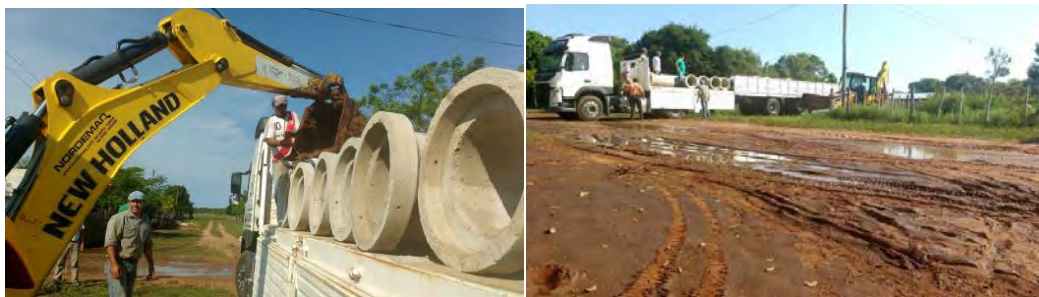
Imagen 28. Obras de entubamiento en Barrios Lllamarada y La Tablada
