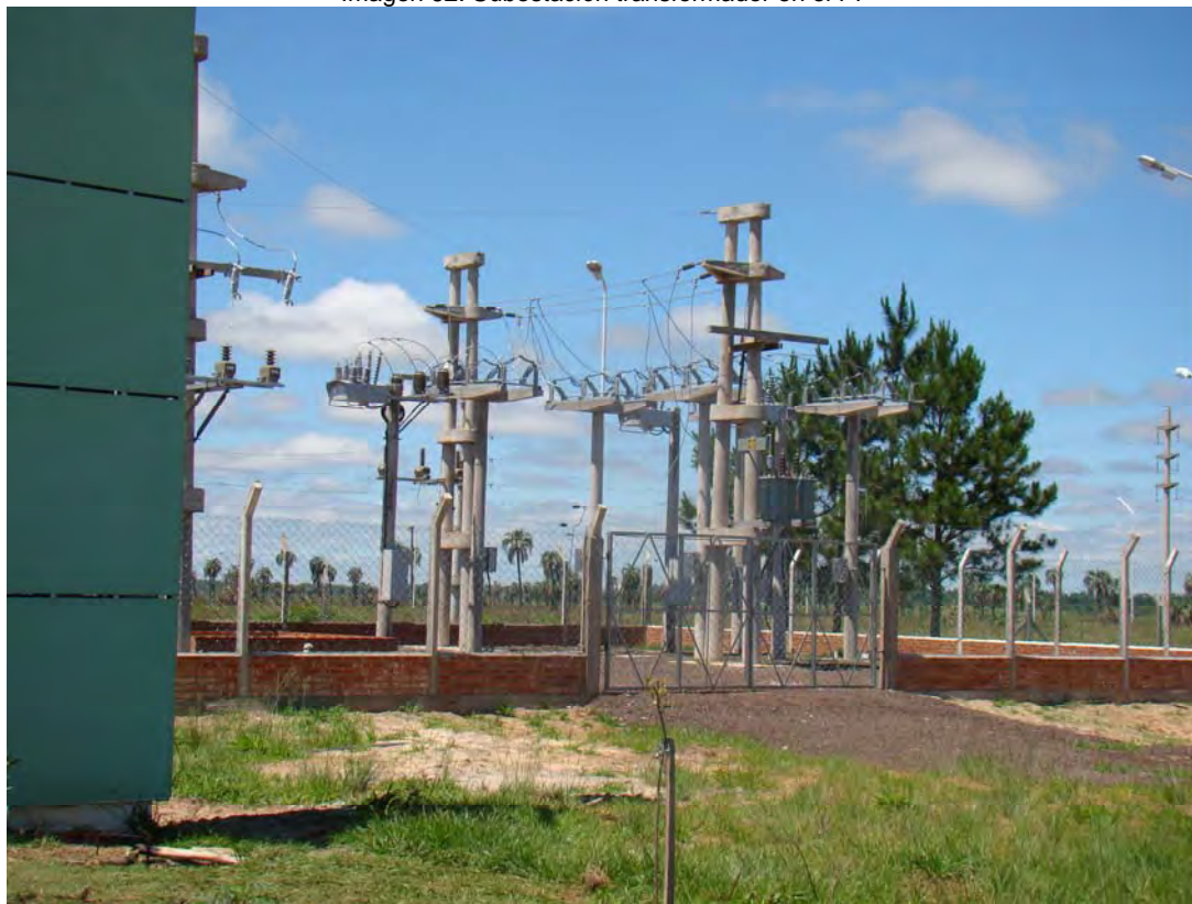
Imagen 62. Subestación transformador en el PI
